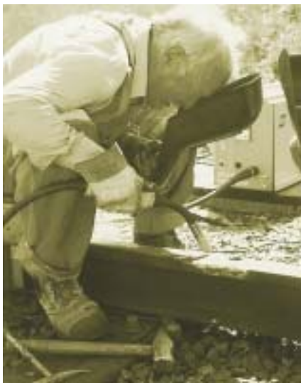
Ремонт на подкопана от колелата релса. OK Tubrodur 15.43
