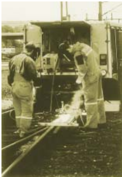
Механизирано заваряване: Railtrack BV/ OK Tubrodur 15.43
