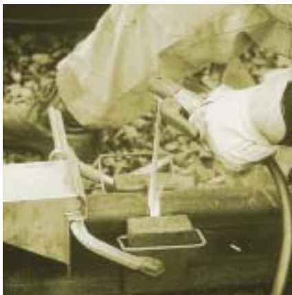
Съединяване на релси чрез заваряване във форми: OK 74.78
