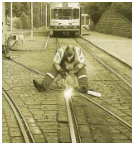
Ремонт на трамвайна релса: OK 67.52
